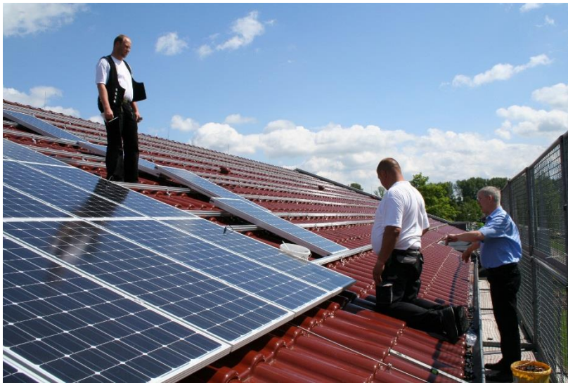
Errichtung einer PV Anlage auf dem eigenen Dach: Fabian Hanker (rechts) mit Handwerkern aus der Region
