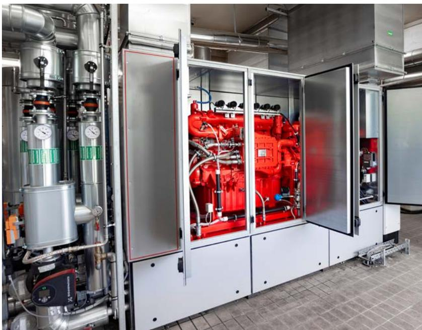
Das neue Blockheizkraftwerk von MAN soll die nächsten 20 Jahre nachhaltig aus Klärgas Wärme und Strom erzeugen.
