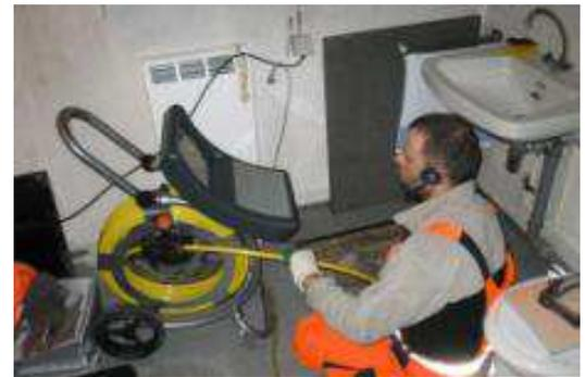
Kanal-TV-Inspektion in einer Kellerrevisionsöffnung mit einer Schiebekamera
