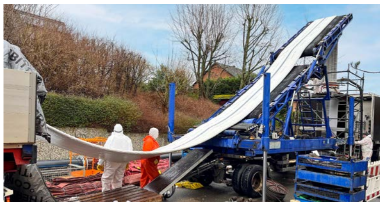
Fast wie in der Medizin: Am Kälberanger wurde ein riesiger Schlauch in den bestehenden Abwasserkanal eingeführt.
