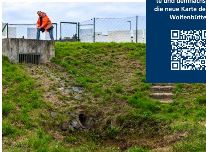
Oben rechts: Moderne Grünstreifen können vieles: Wasser schnell aufnehmen, zurückhalten und langsam versickern oder ablaufen lassen. Unten rechts: Regenrückhaltebecken, wie das im Gewerbegebiet Schweigerstraße, werden bei Starkregen geflutet.
